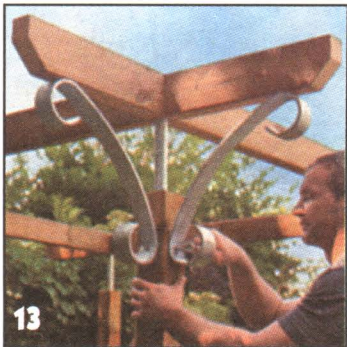
Затянув гайки, к стойкам и выступающим концам несущей рамы привинчивают декоративные детали из оцинкованной стали, выполняющие функцию элементов жёсткости.
