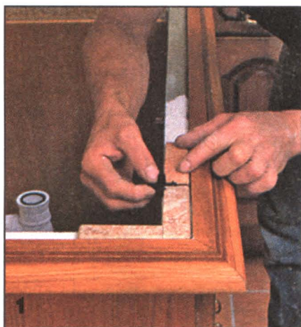
У выреза под мойку рабочую плиту облицовывают узкими полосками плиток, которые укладывают по периметру выреза.
