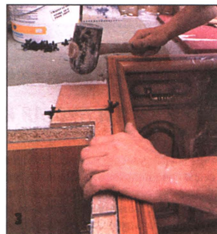
На углу лучше будет смотреться выкроенный из целой плитки Г-образный элемент, к которому примыкает первая целая плитка облицовки рабочей плиты.
