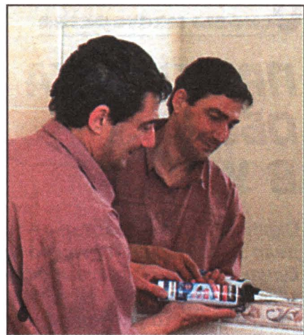
Примерно через два дня гвоздики можно удалить. Дав клею затвердеть (в течение трёх недель), приступают к затирке швов.
