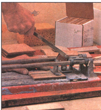
Из квадратных плиток 10x10 см вырезают соответственно три одинаковых по ширине полоски.
